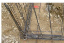
Nœud de chaînage - Continuité mécanique
